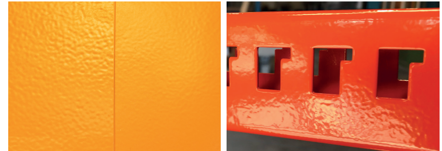
Une épaisseur de couche trop élevée peut entraîner des défauts d'aspect
