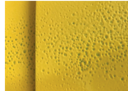
Benetzungsstörungen durch ungenügendes Anhaften des Pulvers
