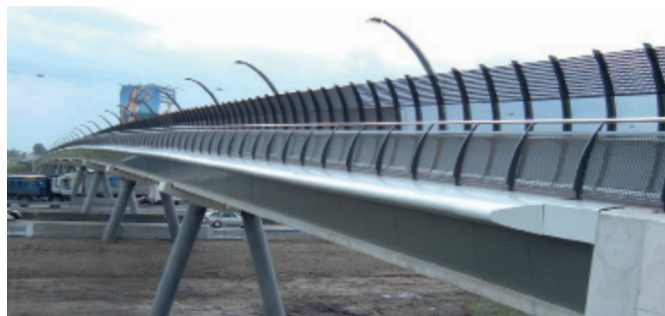
Bridge Leidschenveen, Den Haag
